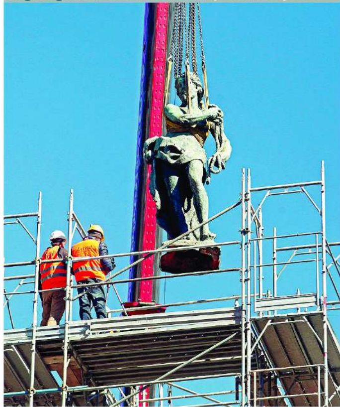
Impalcature La statua del Cristo Redentore staccata e sollevata dalla Colonna del Verziere in largo Augusto (foto Balti)
